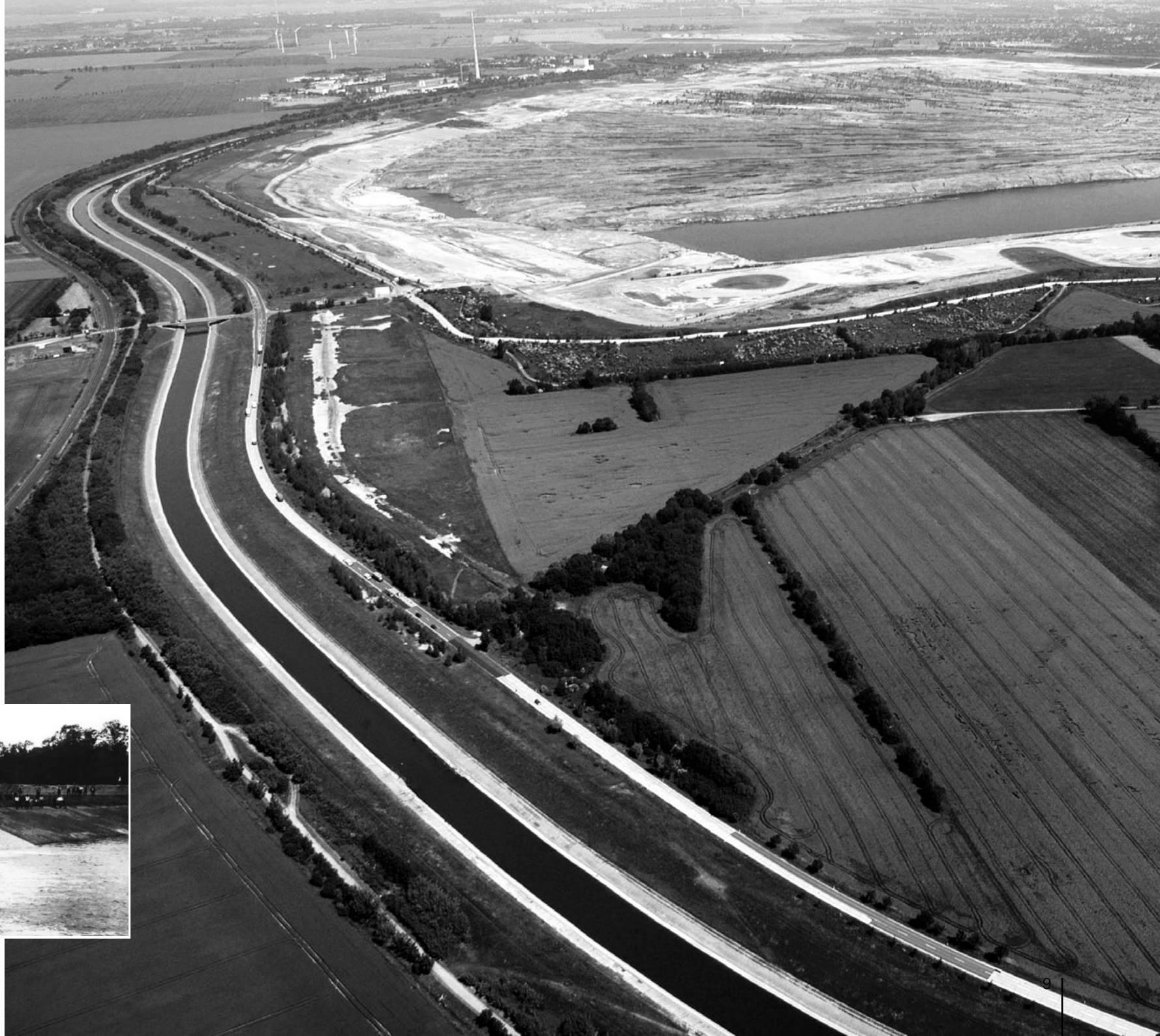
Verlegte Weiße Elster mit Bitumenbeton- dichtung westlich des ehemaligen Tagebaus Zwenkau, dem heutigen Zwenkauer See, 2006
