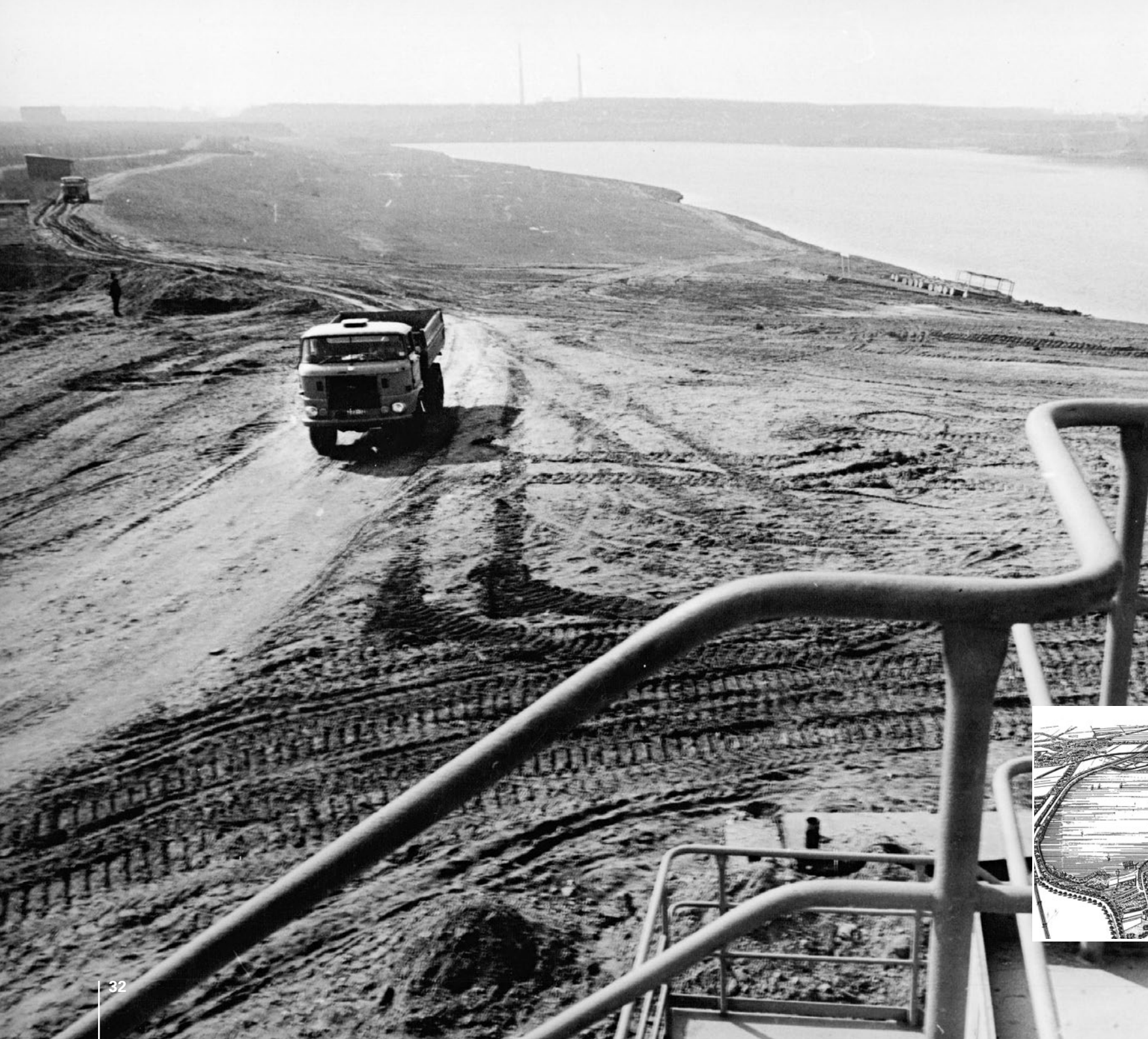
Umfangreiche Erdarbeiten zur Schaffung des Naherholungszentrums Kulkwitzer See, 1973
